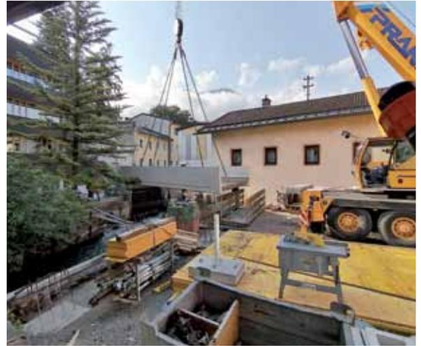
Arbeit aller Beteiligten steht die Brücke nun an der richtigen Stelle. Als nächstes wird sie einbetoniert. Im Anschluss wird der Steinbelag, der die ganze Achenseestraße bedecken wird, auch über die Brücke verlegt. Sie wird für Fußgänger und Radfahrer zugänglich sein, nicht jedoch für Autos.
